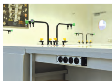
Bandeau au mètre linéaire destiné à la Fixation des Prises en façade de paillasses (A)
