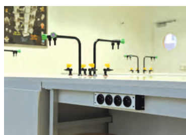
Bandeau au mètre linéaire destiné à la Fixation des Prises en façade de paillasses (A)
